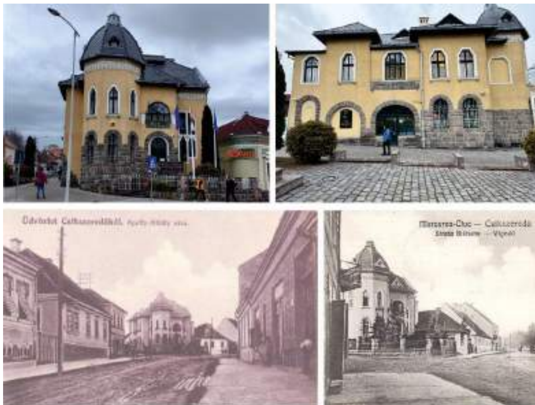
Figura 123 - Clădire – Strada Petofi Sandor nr. 45
