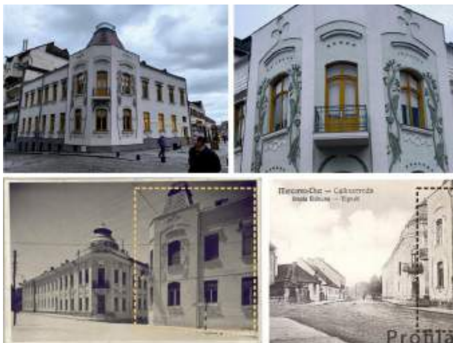
Figura 124 - Clădire – Strada Petofi Sandor nr. 36
