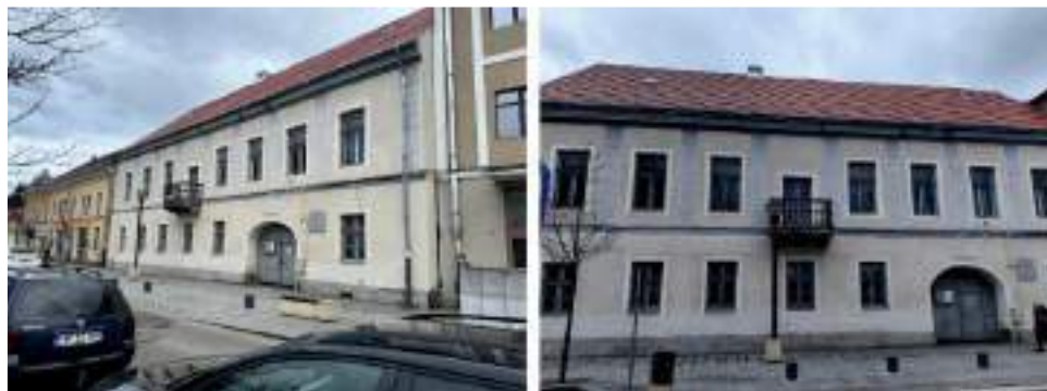
Figura 128 - Clădire – Strada Petofi Sandor nr. 51 Sursa: Autori studiu istoric
