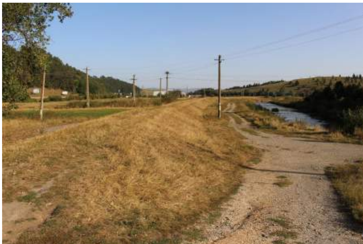
Figura 82 – Dig de protecție la viituri pe râul Olt
