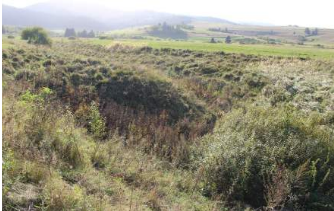
Figura 86 – Zona depresionară de băltire a apei
