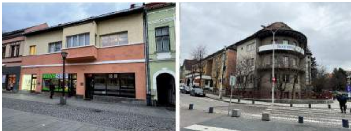
Figura 15 - Exemple de construcții specifice urbanului aparținând stilului Funcționalist din municipiul Miercurea Ciuc Sursa: Autori studiu istoric de fundamentare
